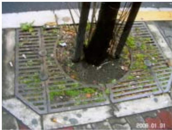
写真4 一般的に歩道で見かける鉄製のすのこ。1m2程で植物にかける負担は大きい。
